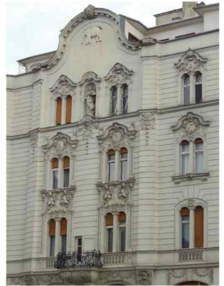
Immeuble rue Vaci N°39 PAK 19 sept. 2016
